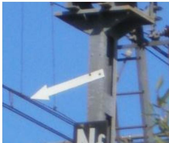
La flèche blanche est utilisée pour indiquer à quelle voie le signal s'adresse lorsque ce dernier est implanté à sa droite (hors Alsace et Moselle et hors ICS). Dans le cas de l'ICS, le signal de sortie de contre-sens doit être fléché.
